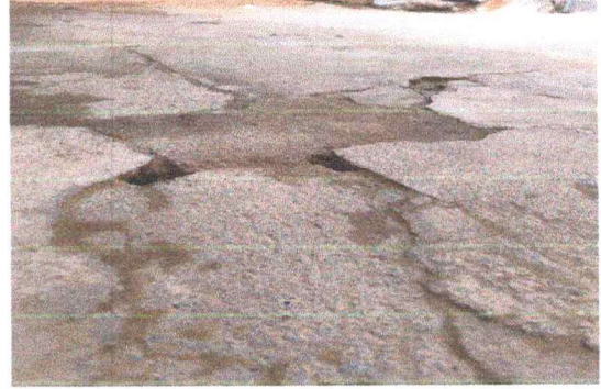
Foto 2: Sustrucción Losa Patio
