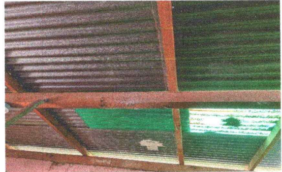
Foto 4: Sustrucción lamina troquelada calibre 26
