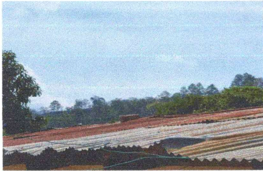
Foto 3: Sustrucción de estructura techo.
