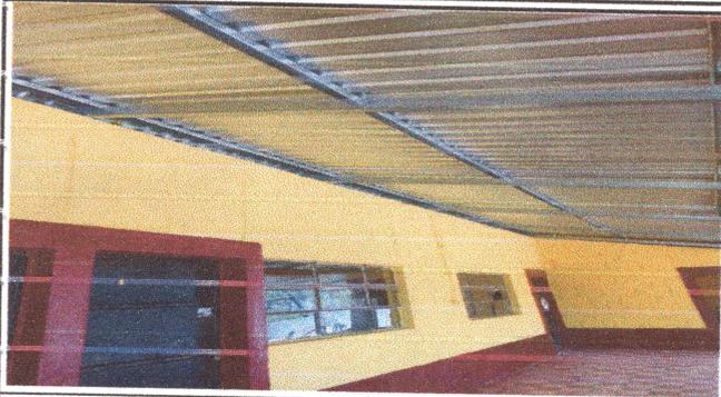
Foto1: Sustitución de cubierta de lamina por lamina troquelada.
