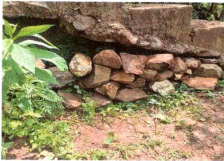
Foto 9: Sustitución de muro de concreto en gradas
