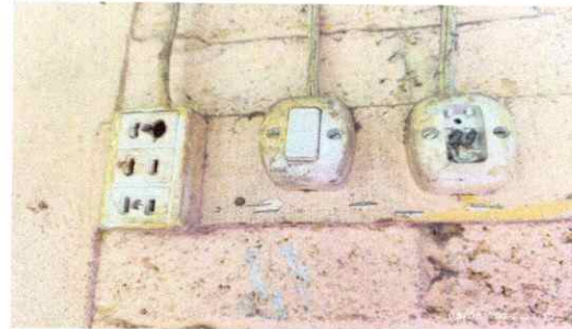
Foto 8: Sustitución de tomacorrientes
