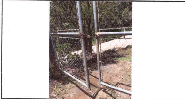
Foto1: MANTENIMIENTO A PORTONES CON COLUMNAS DE CEMENTO Y HIERRO
