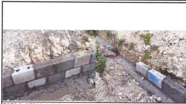
FOTO 2: CERCO O MURO PERIMETRAL
