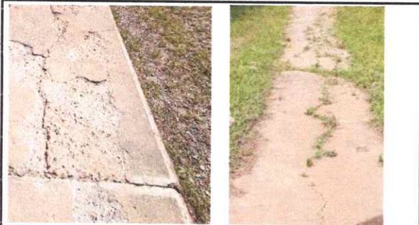
Foto3: LOSA DE PATIO
