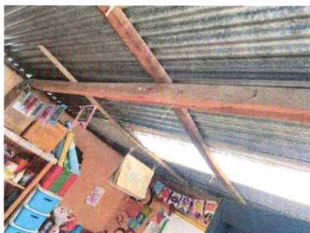
Foto 3: SUSTITUCIÓN DE LÁMINA TROQUELADA CALIBRE 26
