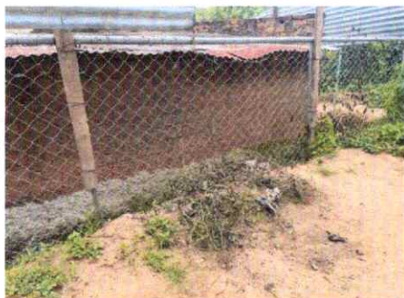
Foto 1: SUSTITUCIÓN DE MURO DE CONCRETO ARMADO
