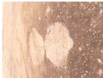
Foto 6: REPARACIÓN LOSA DE PATIO
