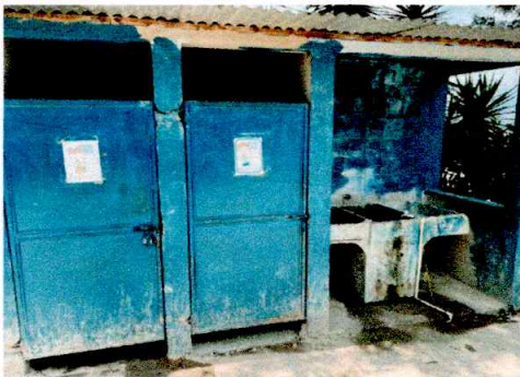
Foto: 5 REPARACION DE PUERTAS
