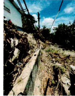
FOTO 2: REPARACION DE MURO PERIMETRAL CON MALLA
