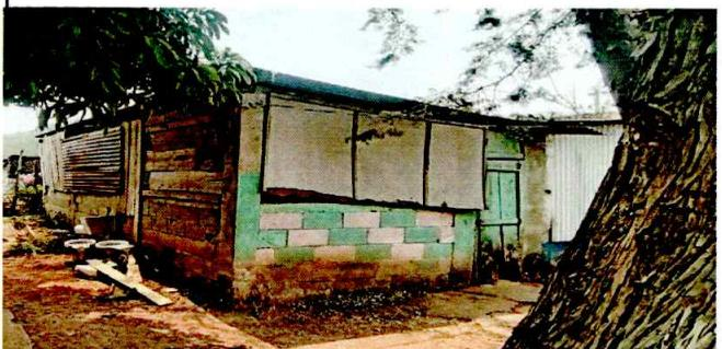
Foto: 6 Levantado de muros de block visto a todo el contorno de las aulas.
