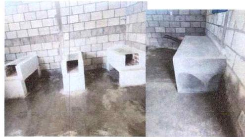
Foto 10: sustitución de piso de cocina, colocación de planchas y mesa de trabajo
