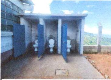
Foto 7: sustitución de pared completa de baños
