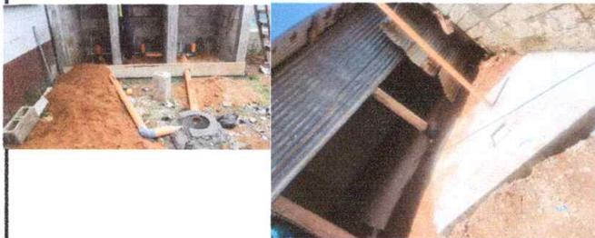
Foto 5: se observa conexión de drenajes, fosa séptica y pozo de absorción
