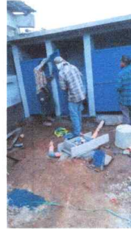
Foto 8: Colocación de puertas de baños
