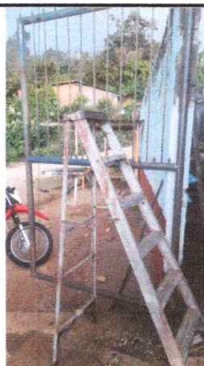
Foto 4: Se observa reparación de portón en proceso
