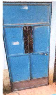
Foto 2: Reparación de puertas
