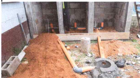
Foto 6: Colocación de drenajes
