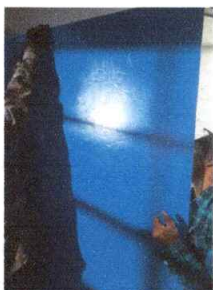
Foto1: Colocación de puerta en cocina
