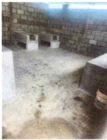
Foto 9: sustitución de piso de cocina
