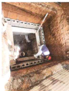
Foto 5: Sustitución de fosa séptica
