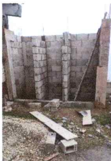
Foto 3: Se observa reposición de paredes de sanitarios
