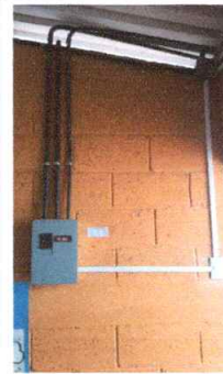
Foto 10: Sustitución de sistema eléctrico
