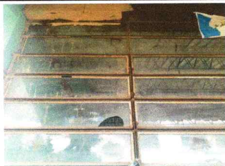
Foto 3: SUSTITUCION DE VENTANAS
