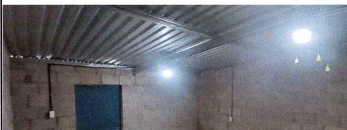
Foto: 5 SISTEMA ELÉCTRICO: Finalizado.
