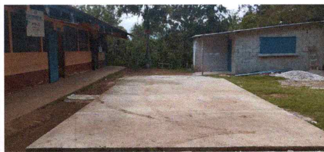
Foto4: LOSA DE PATIO: Finalizada.
