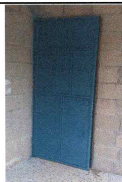
Foto: 6 Puerta de la cocina, colocada.
