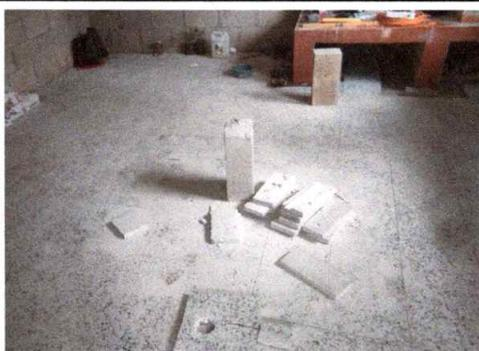
Foto3: COCINA: Colocación de piso en la cocina, en proceso.
