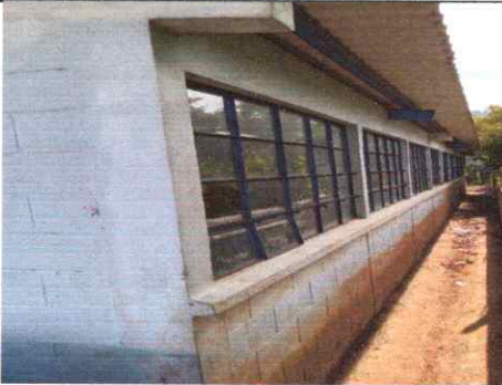
Foto 3: Sustitución de canales y bajadas
