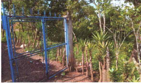
Foto 7: Sustitución de portón con lámina lisa (4.25 X 2.5 mts.)
