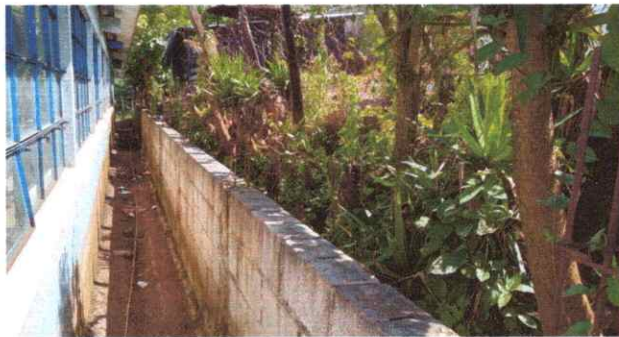
Foto 9: Sustitución muro perimetral block cisado más columnas de concreto esabietadas.
