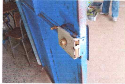
Foto 2: Reparación y mantenimiento puertas en área de aulas
