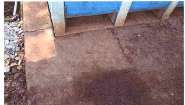
Foto 10: Sustitución losa de patio incluye base, fundición y acabado.
