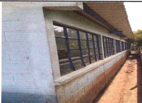
Foto 5: Sustitución de pintura base agua
