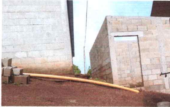
Foto1: Sustitución de área de cocina
