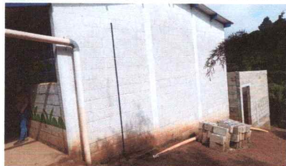
Foto 4: Sustitución de bajadas 4" (incluye codos)
