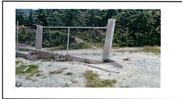
Foto 2: reparación de muro perimetral
