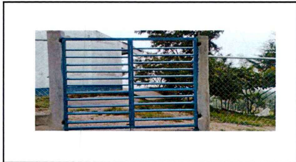
Foto 3: Reparación de porton
