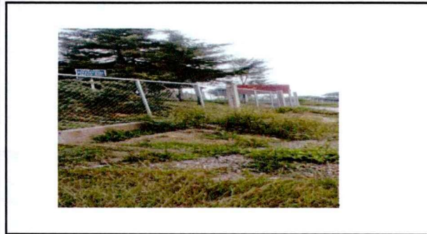
Foto 1: Reparación de muro de contención
