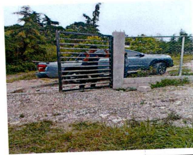
Foto 3: Reparación de porton
