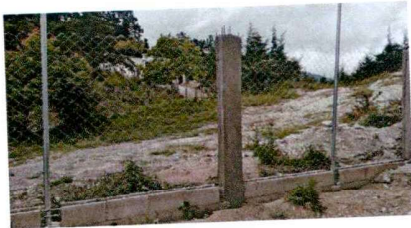
Foto 2: reparación de muro perimetral
