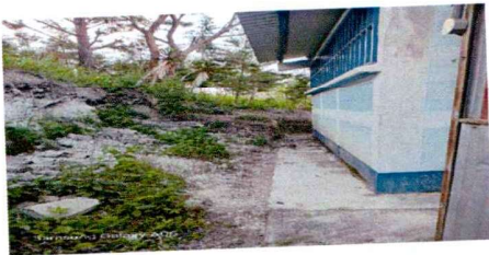
Foto 5: Reparación de drenaje
