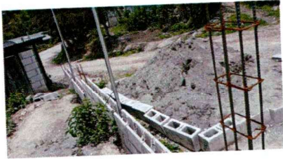
Foto 1: Reparación de muro de contención
