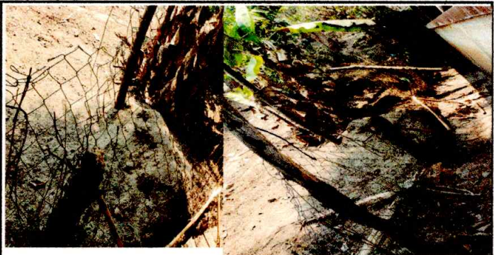
Foto: 6 CERCO O MURO PERIMETRAL
