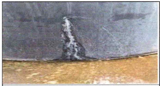
Foto 6: SE OBSERVA ROTOPLAS EN MALAS CONDICIONES
