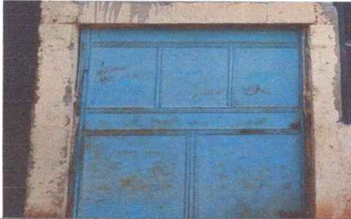
Foto1: REPARACION DE PUERTAS LIJADA Y PINTADA
