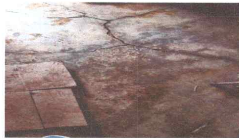
Foto 6: SUSTITUCION DE LOSA DE PATIO
