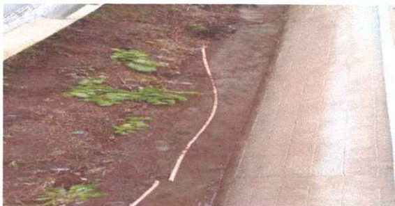
Foto 3: SUSTITUCION DE CUNETA DE CONCRETO
