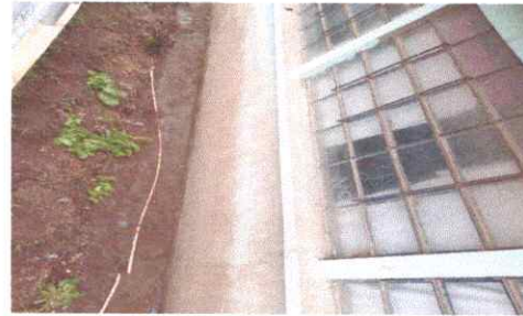
Foto 2: SUSTITUCION DE VIDRIOS
