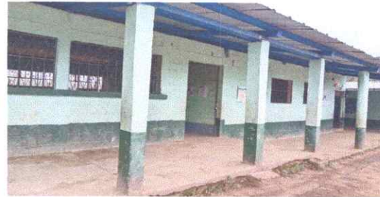
Foto 4: SUSTITUCION DE PINTURA ABASE DE AGUA, A BASE DE ACEITE (ZOCALO)
