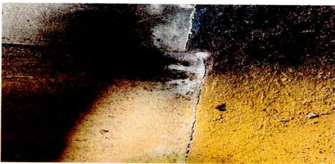
Foto3: SE OBSERVA RAJADURA EN PAREDES DE COCINA
