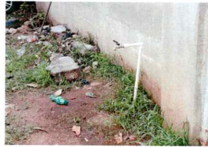
Foto 4: REPARACION DE RED DE DRENAJE Y RED DE AGUA POTABLE
