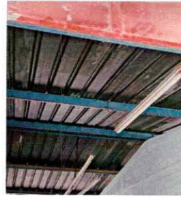
Foto 2: REPARACION DE ESTRUCTURA DE TECHO
