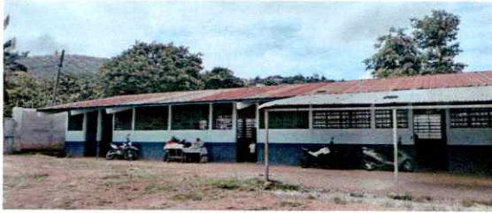
Foto1: SUSTITUCION DE CUBIERTA DE LAMINA (calibre 26)
