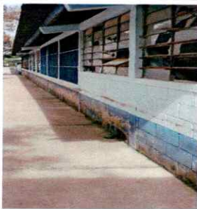
Foto 5: PINTURA EN MUROS EXTERIORES
