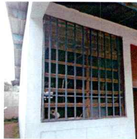
Foto 6: REPARACION DE VENTANALES (sustitucion de vidrios)
