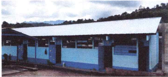
Foto1: Cubierta de lámina
