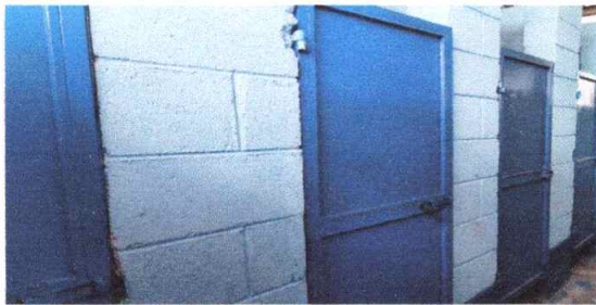
Foto 3: Mantenimiento de puerta
