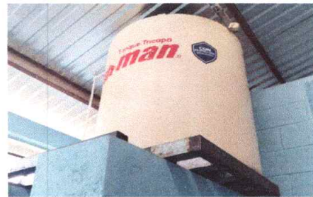
Foto 4: Reparacion y mantenimiento de deposito de agua
