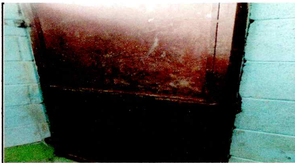
Foto 3: Mantenimiento de puerta
