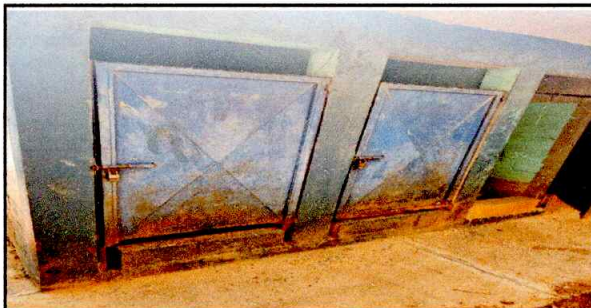
Foto 5: Pintura en muros interiores y exteriores ( area de baños )
