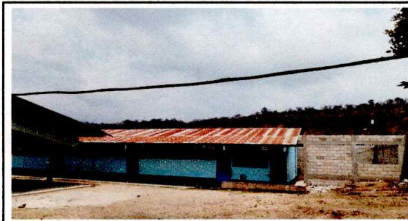
Foto1: Cubierta de lámina
