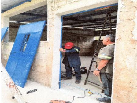
Foto1: cambio de puertas e instalación en proceso
