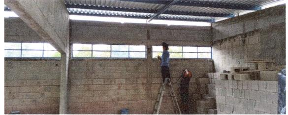
FOTO 2: Instalación de ventanas en proceso
