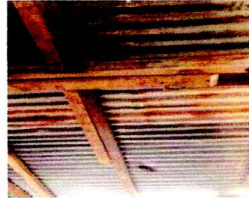
Cambio de techo por deterioro.
