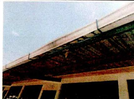
Foto 2: CANALES Y BAJADAS DE AGUA PLUVIAL (SUSTITUCIÓN DE CANAL CUADRADO GALVANIZADO)
