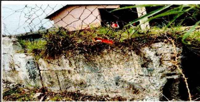
Foto 1: Se evidencia muro perimetral deteriorada
