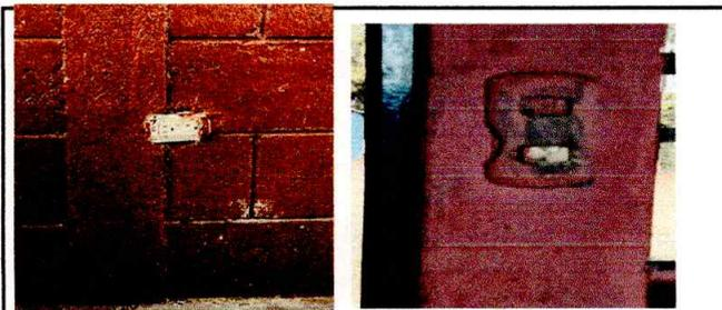
Foto 3: se evidencia tomacorrientes en mal estado en tres aulas
