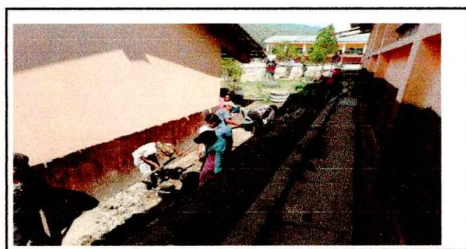
Foto 6: SUSTITUCIÓN DE LOSA DE PATIO POR FILTRACIONES
