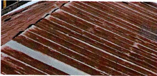
Foto1: CUBIERTA DE LAMINA (calibre 26)
