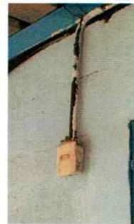
Foto 4: INSTALACION DE INTERUPTORES
