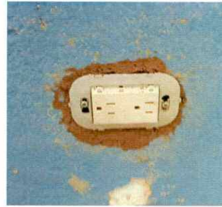
Foto 2: INSTALACION DE TOMACORRIENTES
