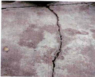
Foto 5: LOSA DE PATIO
