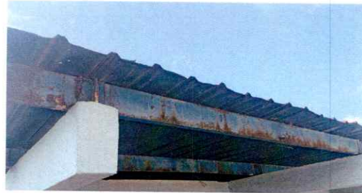
Foto 2: ESTRUCTURA DE TECHO
