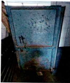
Foto 3: PUERTAS DE BAÑO (reparaciones)
