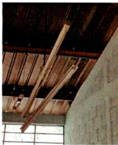
Foto 3: INSTALACION DE LAMPARAS
