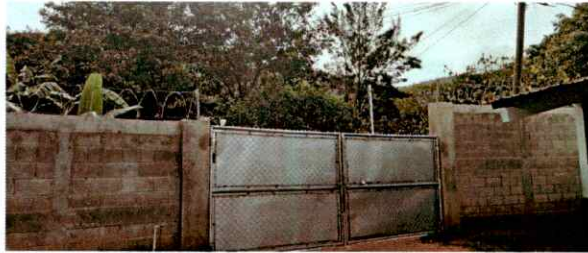
Foto 1: REPARACION DE RAZOR RIBBON
