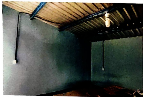
Foto 4: Repello y cernido de paredes
