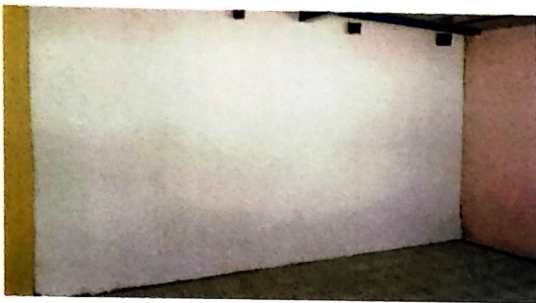
Foto 3: Repello y cernido de paredes
