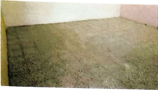
Foto 1: Cambio de losa por piso
