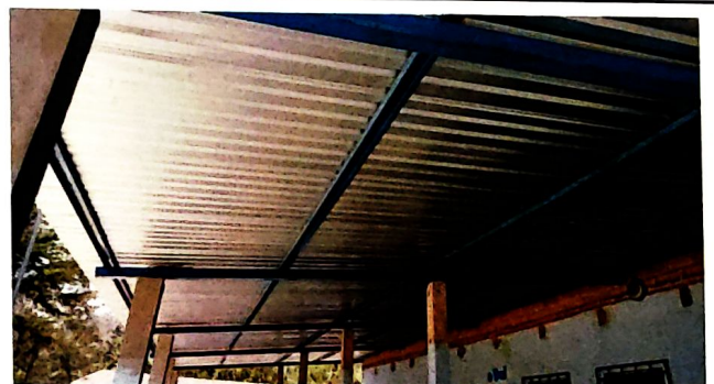
Foto 6: Reparación estructura de techo
