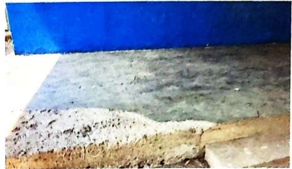
FOTO 2: REPARACION DE LOSA
