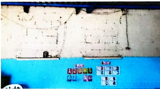
Foto3: REPELLO Y CERNIDO DE PAREDES
