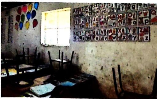
Foto 5: PINTURA MUROS INTERIOR Y EXTERIOR
