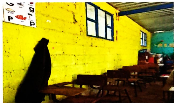
Foto4: REPELLO Y CERNIDO DE PAREDES
