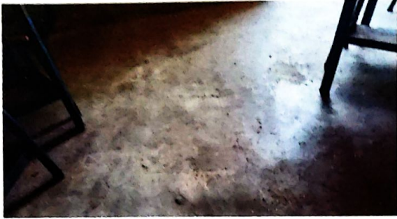
Foto1: CAMBIO LOSA POR PISO
