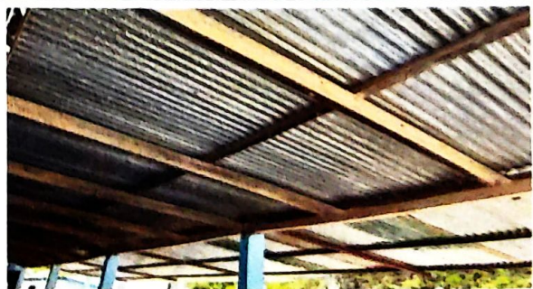
Foto 6: REPARACION ESTRUCTURA DE TECHO
