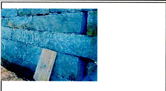
Foto 2: Reparación de muro de contención
