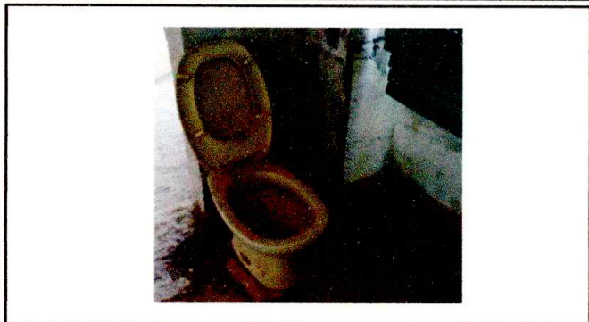
Foto 1: Reparación de servicios sanitarios y sus accesorios
