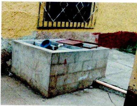
Foto: 5 REPARACION DE FILTRACION DE PILAS, INSTALACION DE AZULEJO EN PAREDES INTERNAS.
