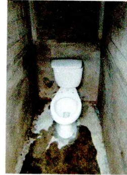
FOTO 2: REPARACION DEL MODULO DE BAÑOS
