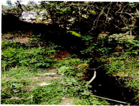
Foto3: REPARACION DE CUNETA DE CONCRETO
