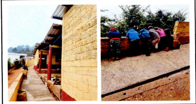
FOTO 2: MURO PERIMETRAL CON MALLA
