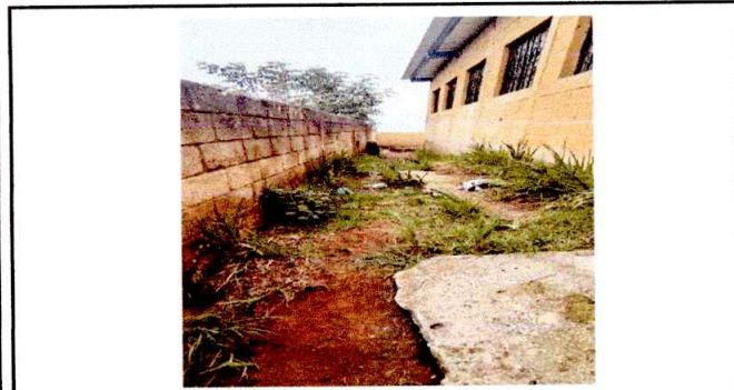
Foto 3: LOSA DE PATIO
