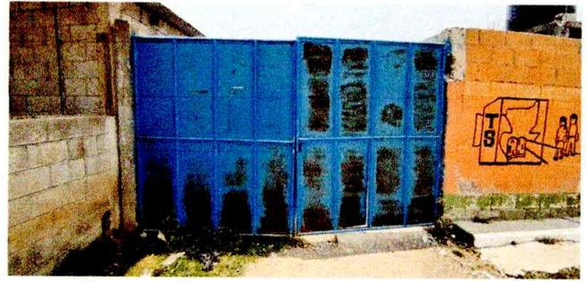
FOTO 2: MANTENIMIENTO A PORTON (cambio de chapa, pintura y marco metálico)
