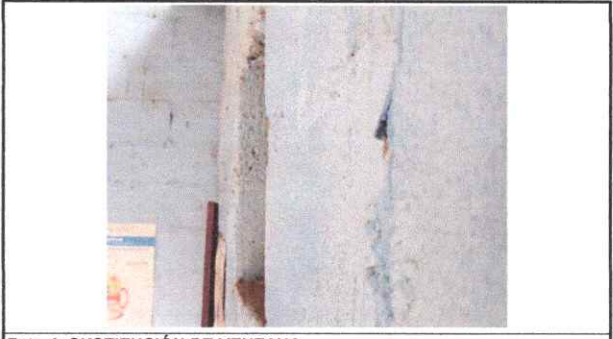
Foto 4: SUSTITUCIÓN DE VENTANA
