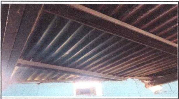
Foto 2: ESTRUCTURA DE TECHO
