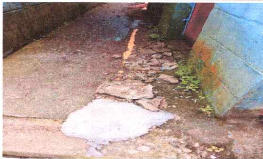
Foto 3: Sustitución red de drenaje
