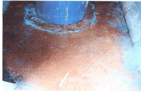
Foto 2: sustitución de sanitario
