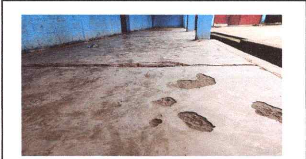
Foto 5: SUSTITUCIÓN DE PISO DE CEMENT
