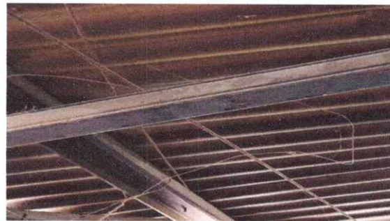
Foto 4: Sustitución de sistema electrico
