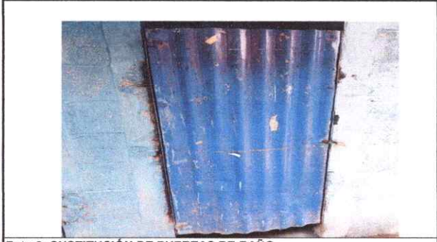
Foto 3: SUSTITUCIÓN DE PUERTAS DE BAÑO
