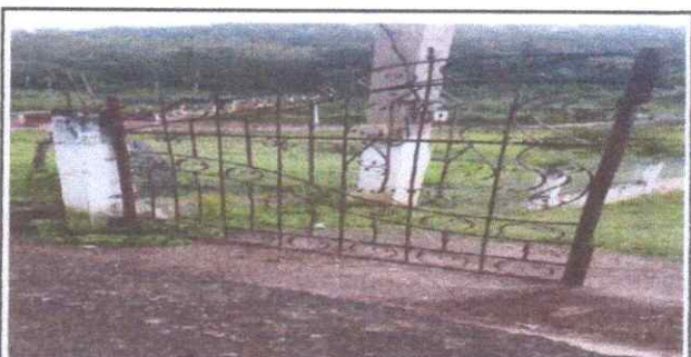
Foto 4: REPARACION Y MANTENIMIENTO DE PORTON
