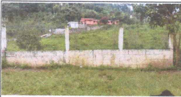
Foto 5: SUSTITUCION DE MURO PERIMETRAL CON BLOCK Y MALLA
