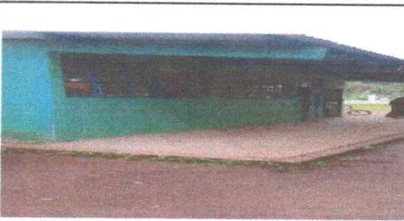
Foto 3: SUSTITUCION DE PINTURA BASE DE ACEITE
