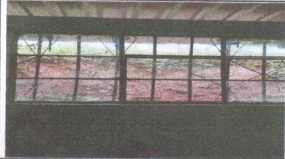
Foto 1: SUSTITUCION DE VIDRIOS MEDIDAS TÍPICAS
