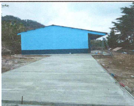
Foto 5: Losa de patio
