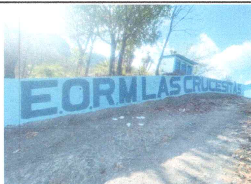
Foto 6: Pintura en muros interior y exterior
