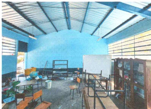
Foto 1: Estructura de techo y cubierta de lamina
