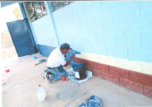
Foto 5: Pintura en muros
