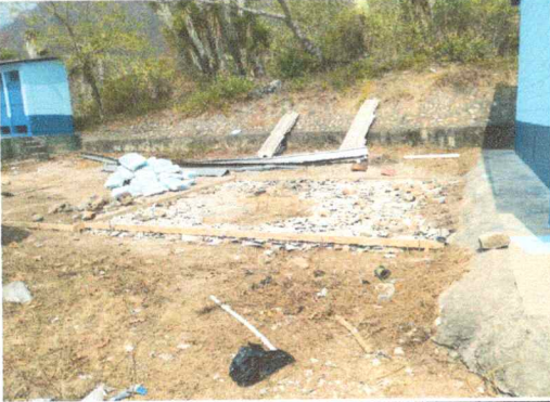
Foto 1: Losa de patio
