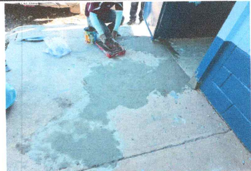
Foto 6: Losa de patio
