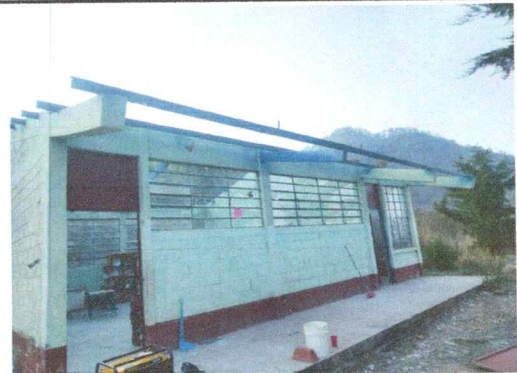
Foto 4: Cubierta de lamina
