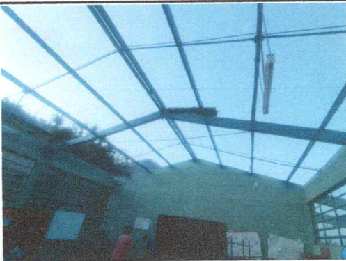
Foto 3: Estructura de techo
