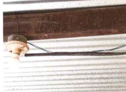
Foto 8: SUSTITUCION DE CABLEADO ALAMBRE CALIBRE 12 MAS TUVO DUCTO SOBREPUESTO, SUSTITUCION DE LAMPARA LED INCLUYE INTERRUPTOR
