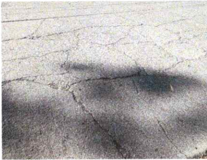
Foto 7: SUSTITUCION LOSA DE PATIO INCLUYE BASE, FUNDICION MAS ACABADO
