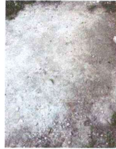
Foto 2: REPARACION DE PISO
