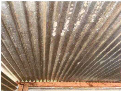
Foto 3: CUBIERTA DE LAMINA
