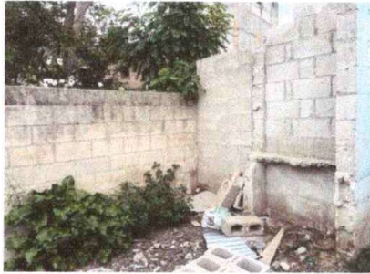
Foto1: REPARACION DE AREA DE COCINA
