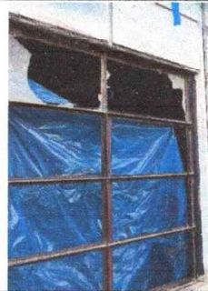
Foto4: REPARACIÓN DE VENTANA
