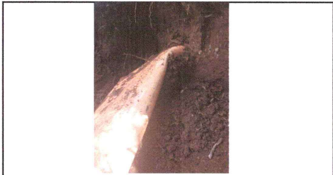
Foto 3: REPARACIÓN DE RED DE DRENAJWS Y RED DE AGUA POTABLE
