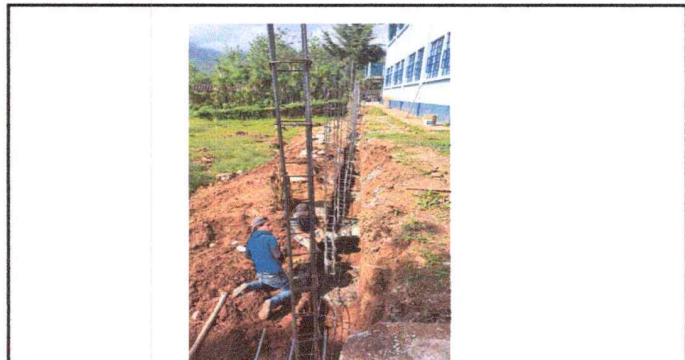
Foto 4: REPOSICIÓN DE MURO
