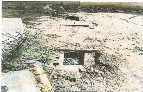
Foto3: REPARACION DE RED DE DRENAJES Y RED DE AGUA POTABLE
