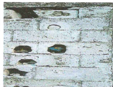
Foto4: REPOSICIÓN DE MURO
