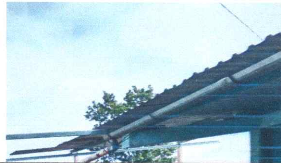
Foto 2: SUSTITUCION DE CANALES Y BAJADAS DE AGUA (3")
