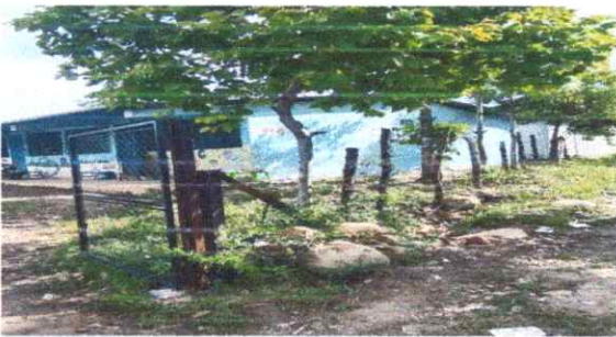
Foto 5: REPARACION Y MANTENIMIENTO A PORTONES
