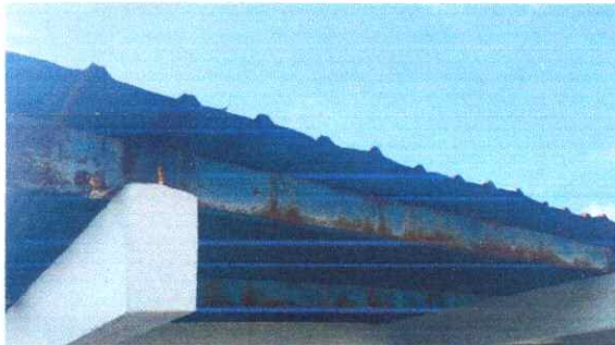
Foto 3: SUSTITUCION DE ESTRUCTURA DE TECHO
