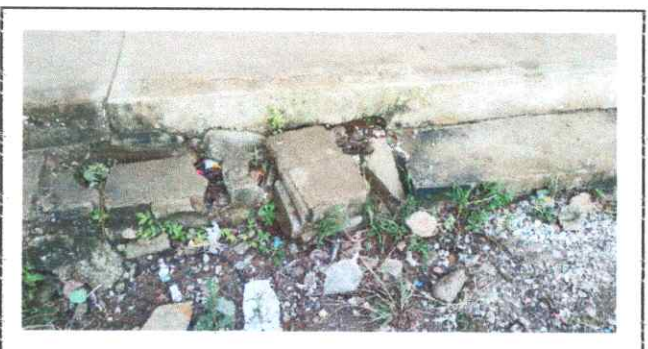
Foto 4: LOSA DE PATIO
