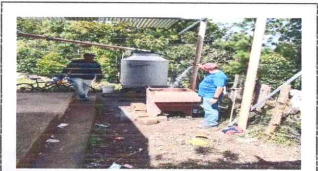
Foto 3: REPARACION DE DRENAJE Y RED DE AGUA
