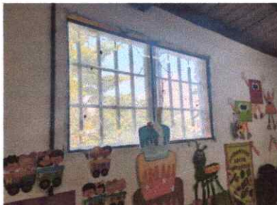
Foto 5: Sustrucción de ventana en mal estado
