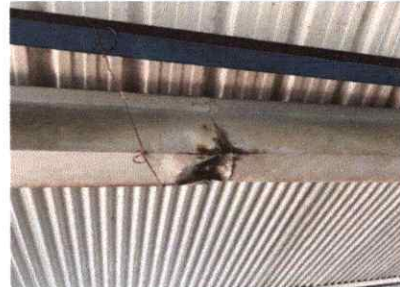
Foto 2: Sustrucción de canal en mal estado
