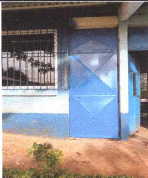
FOTO 3: SUSTITUCIÓN DE PUERTA DE METAL PARA MAYOR SEGURIDAD
