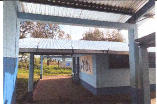
FOTO 2: CAMBIO DE CUBIERTA DE TECHO EN AREA DE DIRECCIÓN
