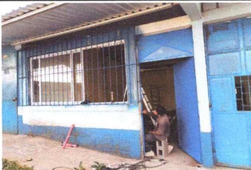
Foto 5: Fabricación e instalación de puerta y ventana en bodega.
