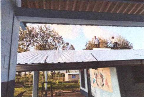
FOTO 1: Cambio de cubierta de lámina en área de dirección
