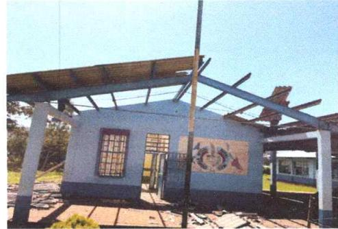
FOTO 2: Desmontaje de lámina para realizar el cambio de cubierta.
