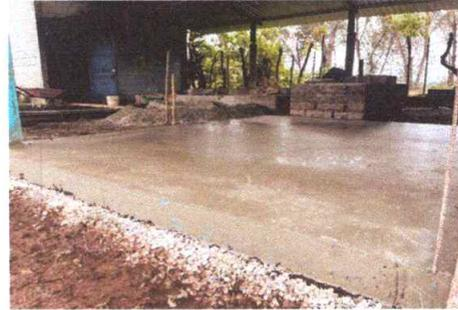
Foto 4: Fundición de losa de concreto para cocina.
