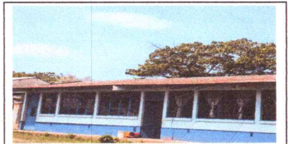
Foto 6: CUBIERTA DE LAMINA
