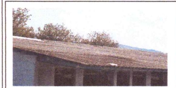
Foto 1: CUBIERTA DE LAMINA
