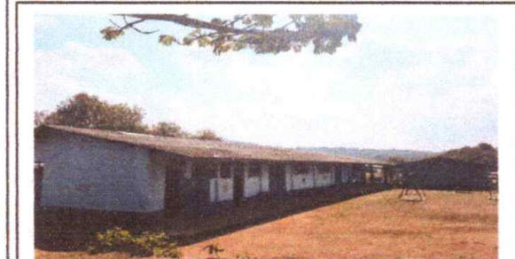
Foto 3: CUBIERTA DE LAMINA
