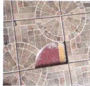
Foto 4: Cambio de piso existente (PISO GRANITO)
