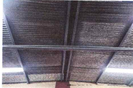
Foto 2: Estructura metalica para techo (sustitucion)
