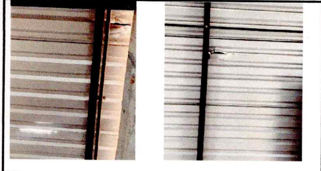
Foto1: CUBIERTA DE LAMINA Y ESTRUCTURA DE TECHO
