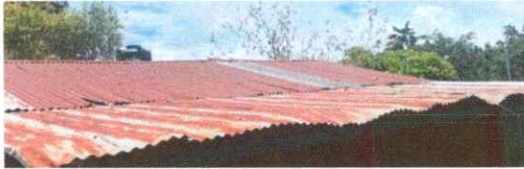
Foto1: SUSTITUCIÓN LAMINA TROQUELADA CALIBRE 26
