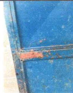
Foto 4: SUSTITUCIÓN PUERTAS EN AREA DE AULAS
