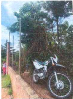
Foto 3: SUSTITUCIÓN DE CERCO PERIMETRAL CON BLOCK Y MALLA
